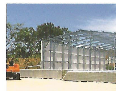
Installation des parois
