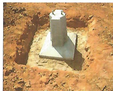
Pose de blocs de fondation en béton
