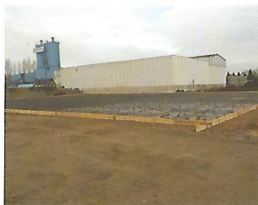
Préparation du site
