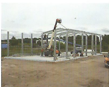
Montage des profils
