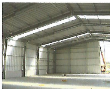
Mise en place des finitions
