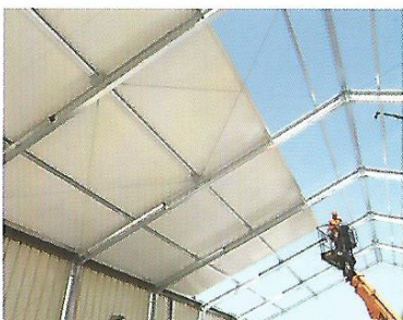
Pose de la toiture
