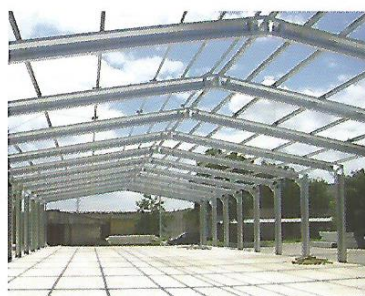
Montage de la structure
